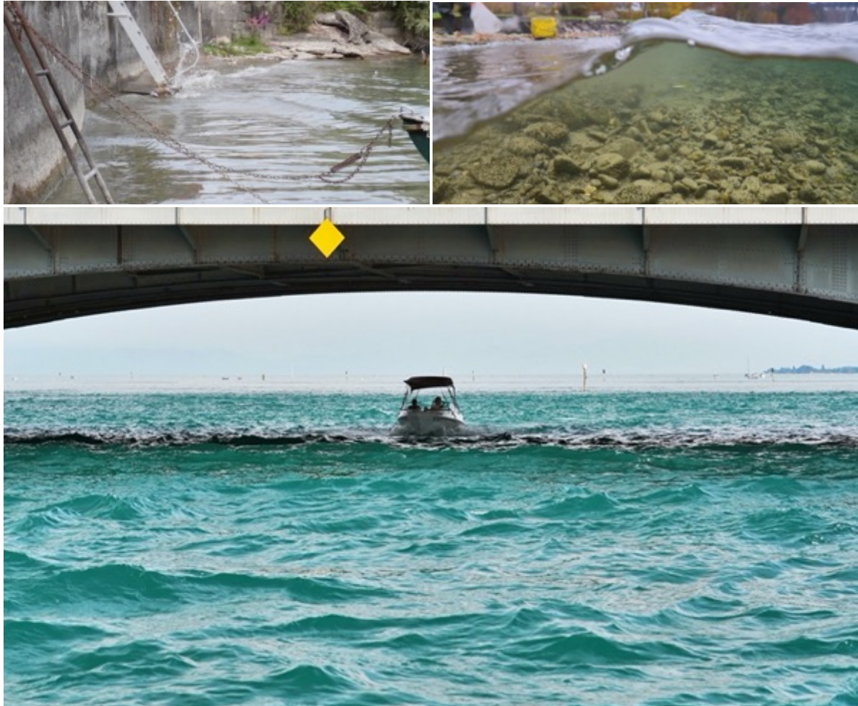
Abb. 5.32: Oben links: Die durch Motorschiffe erzeugten Bugwellen reflektieren an der Ufermauer. Oben rechts: die sich nach und nach aufbauenden «spitzen» Wellen führen zu einer Aufwirbelung von Feinsedimenten auf der Sohle bis in ca. 1 m Wassertiefe. Unten: Alte Rheinbrücke bei Konstanz, Blick nach Osten: Während der See im breiteren Teil der Konstanzer Bucht (Bildhintergrund) eine glatte Oberfläche aufweist, bauen sich im Konstanzer Trichter und vor allem im oberen Seerheinabschnitt im Verlauf des Tages Wellenberge auf, die durch überschneidende Bugwellen und Wellenreflexionen am Uferverbau entstehen. Fotos: Rey.
