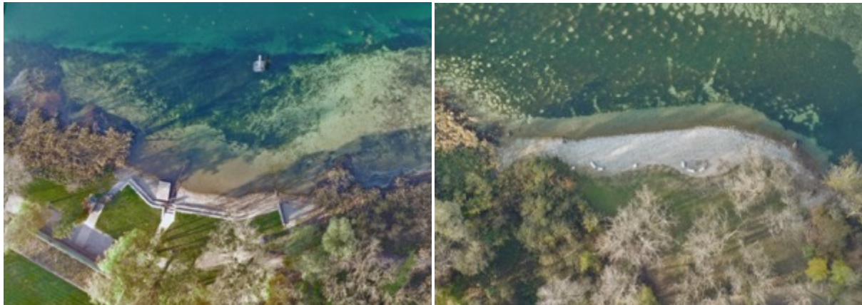
Abb. 5.27: Kiesvorschütten vor der Badi Gottlieben (links) und am Rastplatz Kuhhorn (rechts) reichen nur bis in die oberste Wasserwechselzone und sind für kieslaichende Fische nicht nutzbar. Foto: Rey
