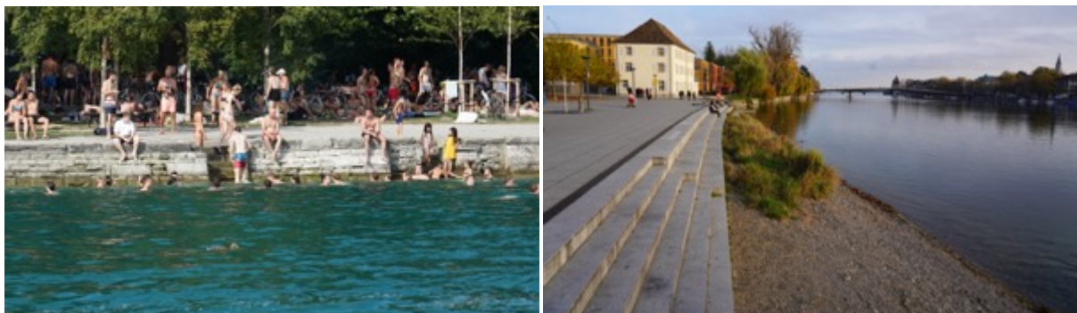
Abb. 5.19: links: Uferverbau unterhalb der alten Konstanzer Rheinbrücke. Rechts: Kiesvorschüttungen vor der neuen Seerheinpromenade. Fotos: Rey.
